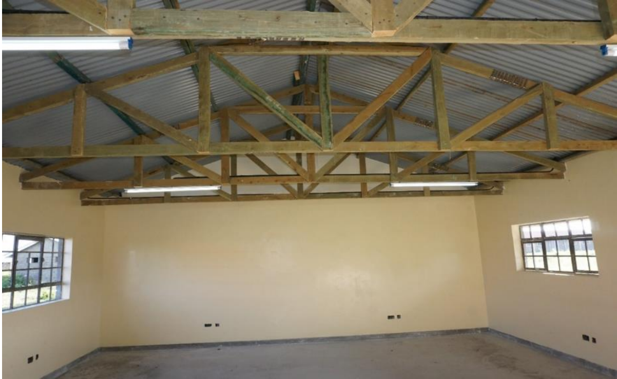
Innenansicht eines neuen Klassenraumes mit Betonboden.
