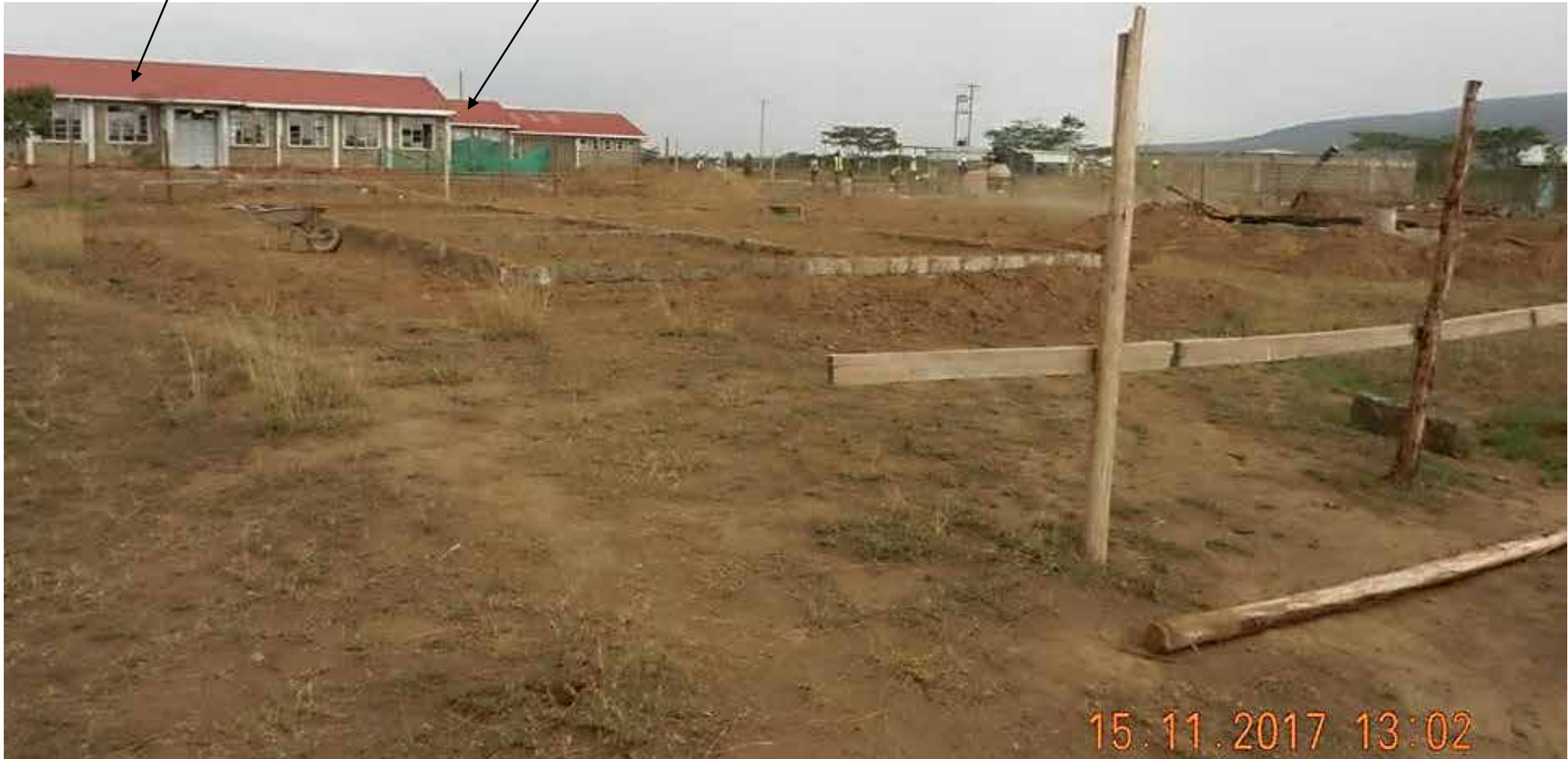
Einrichtung der Baustelle
