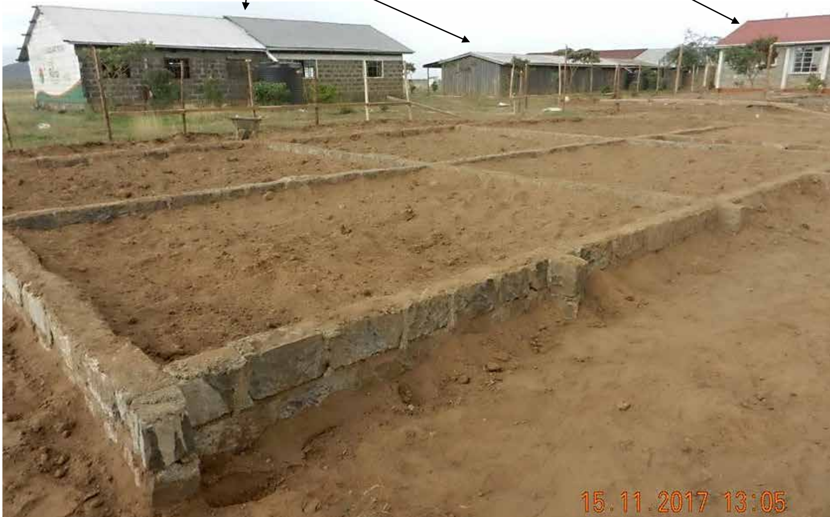
Außenmauer-Fundamente für Jungen-Speisesaal-Gebäude
