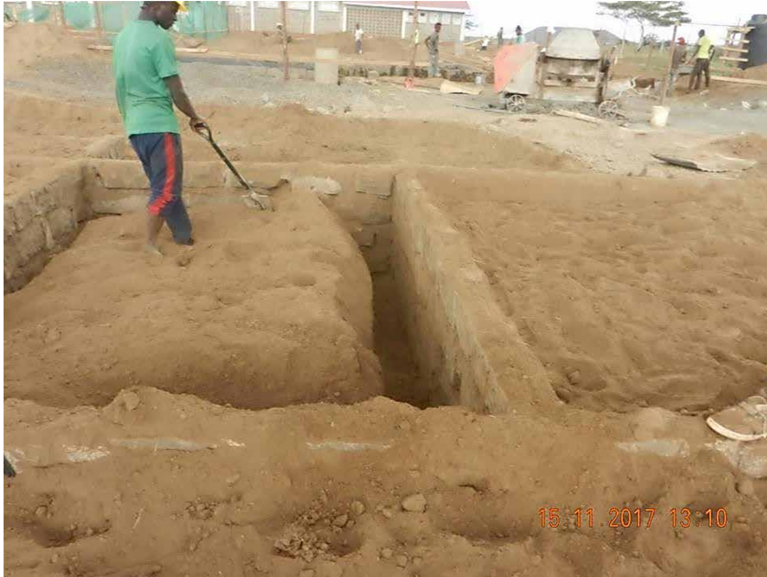
Auch bei der 2. Bauphase viel Handarbeit
