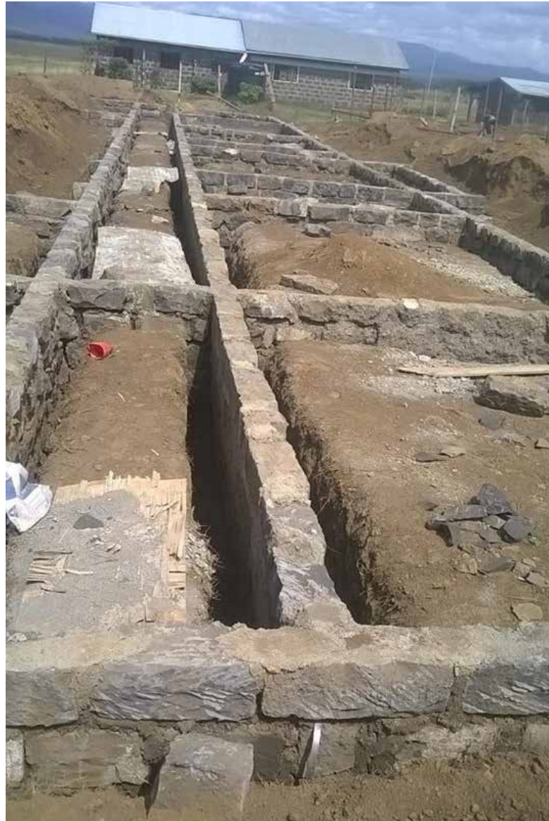
Außenmauer-Fundamente für eines der Jungen-Schlafsaal-Gebäude (1)
