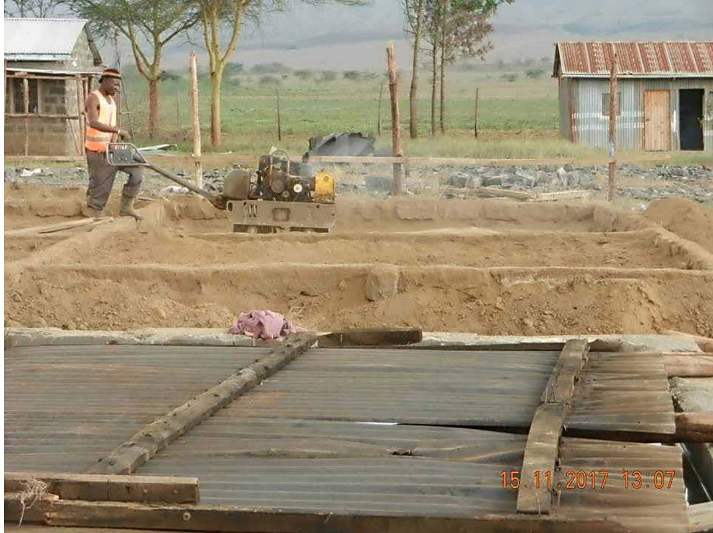
Hier wird erstmals ein Rüttler verwendet. Im Hintergrund: Vorhandene Lehrerunterkünfte
