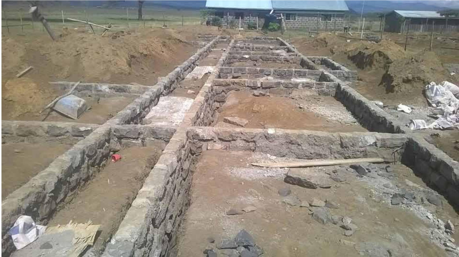
Fundamente und Grundmauern für eines der Jungen-Schlafsaal-Gebäude (3) Im Hintergrund: Bereits existierende Lehrer-Unterkünfte
