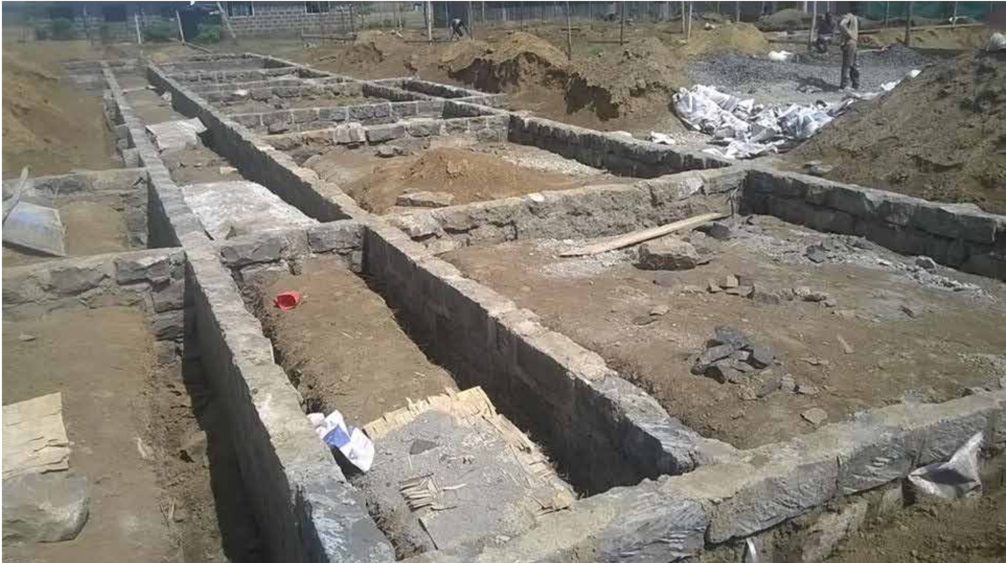
Außenmauer-Fundamente für eines der Jungen-Schlafsaal-Gebäude (2)
