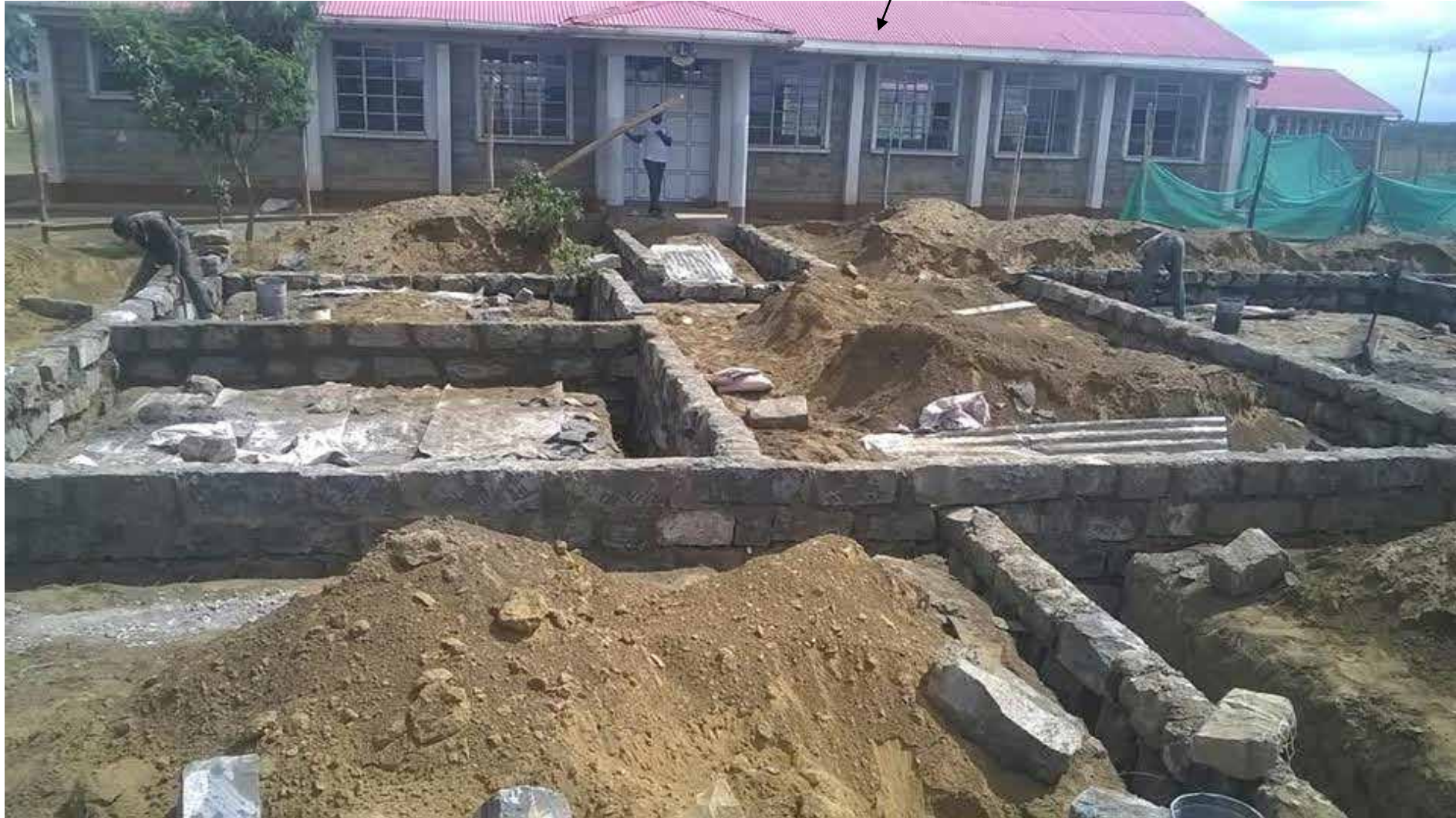
Fundamente und Grundmauern für Jungen-Speisesaal und 3 Gast-Unterkünfte mit Nassräumen (2)
