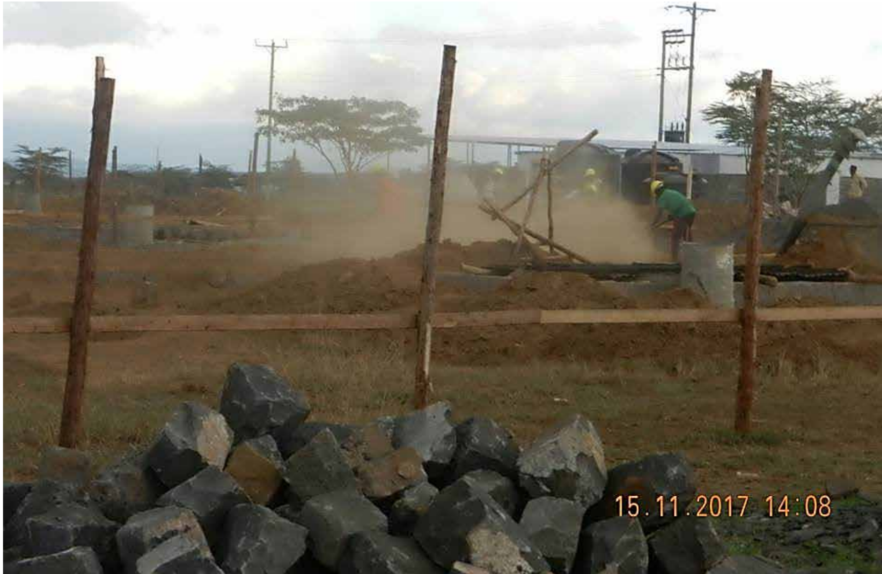
Weitere Vorbereitungsarbeiten auf der Baustelle
