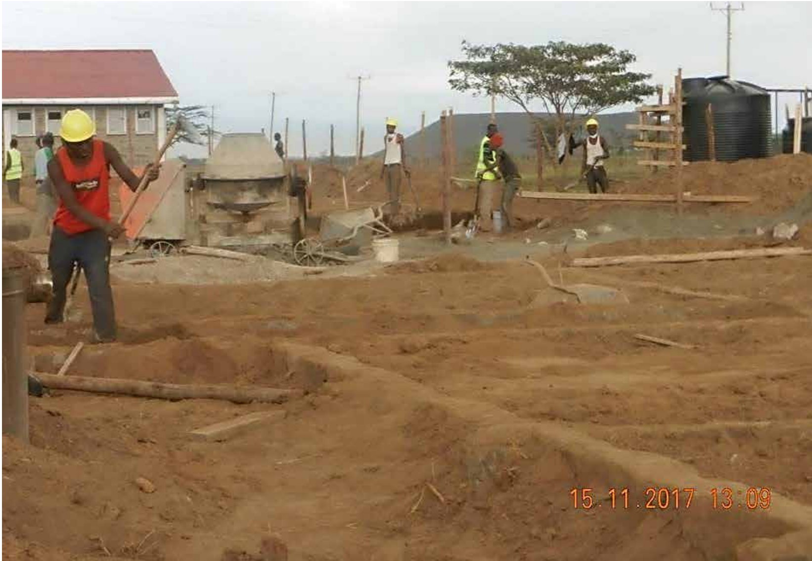
Bauphase 2: Einrichtung der Baustelle und Fundamentierungsarbeiten
